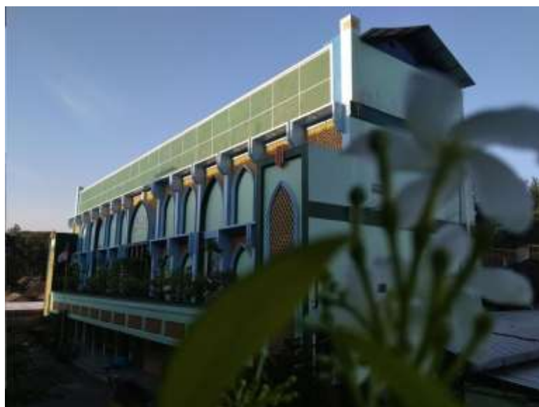
Gambar 4.12 Gedung Pondok Pesantren, Kamar Mandi dan Tempat Jemuran
